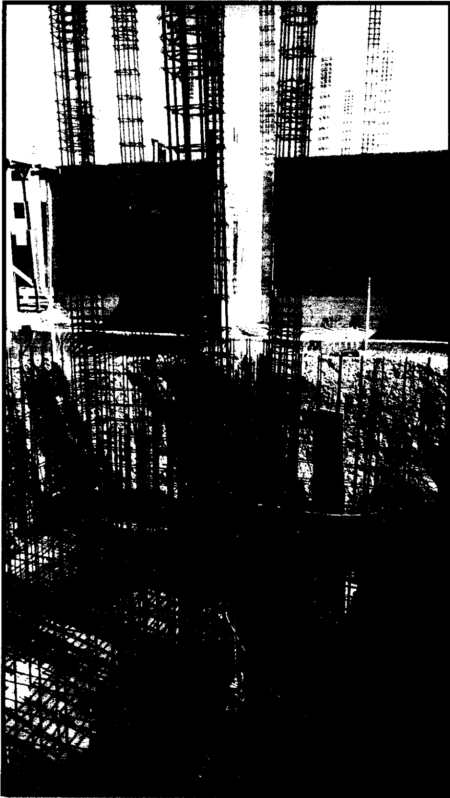
Figura 11: Armadura expuesta en Cisterna-Tanque Elevado
